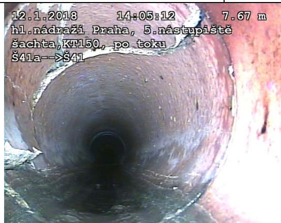
FOTO103: Otevřená prasklina 1/2Ø potrubí
