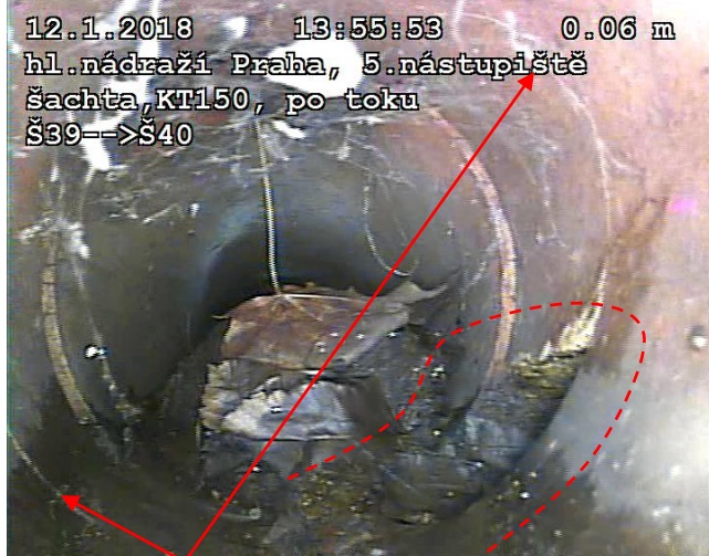
FOTO99: Prasklina, vyložený střep, dále potrubí zanesené
