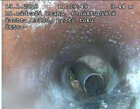
FOTO123: Nastrčené potrubí malého profilu
